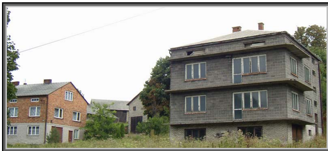
rys. 1 Widok na budynki mieszkalne pokryte eternitem, m. Strzegowa [fot. Autorzy].
